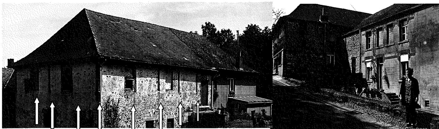
On peut observer ci-dessus les pièces de bois verticales encastrées dans la maçonnerie. Initialement (1690), il n'y avait que les poutres qui soutenaient la charpente du toit et laissaient à l'air libre une terrasse de séchage à papier. Lors de sa conversion (1855) en moulin à moudre grains, on a rebouché les ajours.
